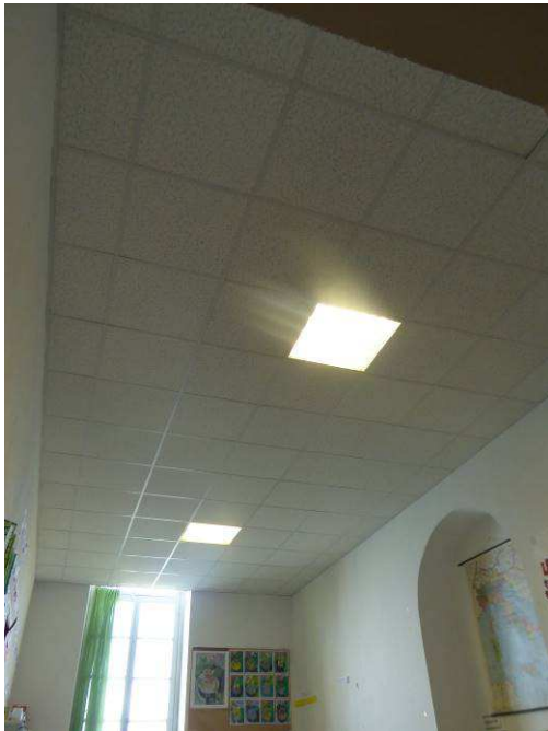
Figura 8: Aula A7 controsoffitto in lamierino e pannelli Foto P1080287 1080284.
