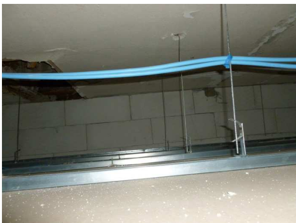
Cavi elettrici appesi ai pendini con nastro isolante Plafoniere fissate in maniera non idonea
