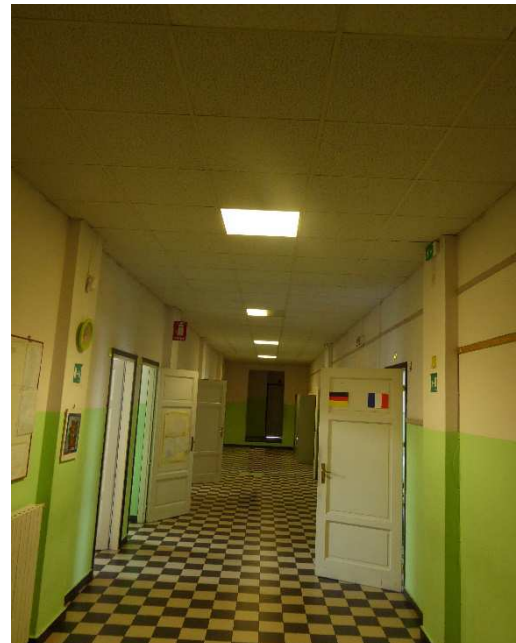
Figura 15: Corridoio C1 controsoffitto in I pannelli – Foto P1080313
