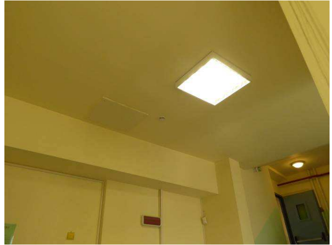
Figura 17: Ingresso – controsoffitto in cartongesso Foto P1080311
