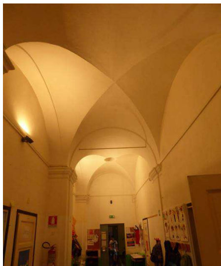
Figura 6: Corridoio – Volta a crociera – Foto P1080276.
