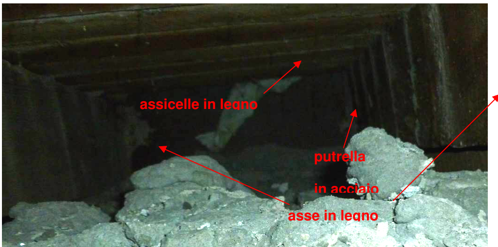
Figura 26: Particolare sezione del solaio.
