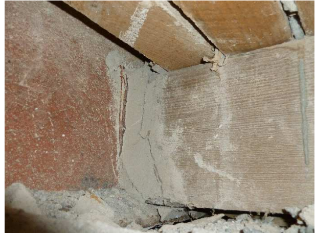
Figura 25:Aula A7 – particolare della struttura del solaio
