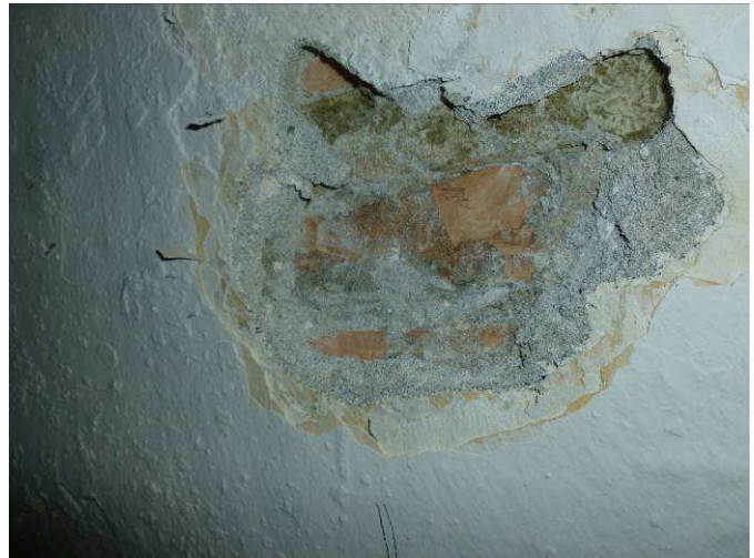
Figura 20: Volta – locale servizi B1 – Stratigrafia Foto P1040082
