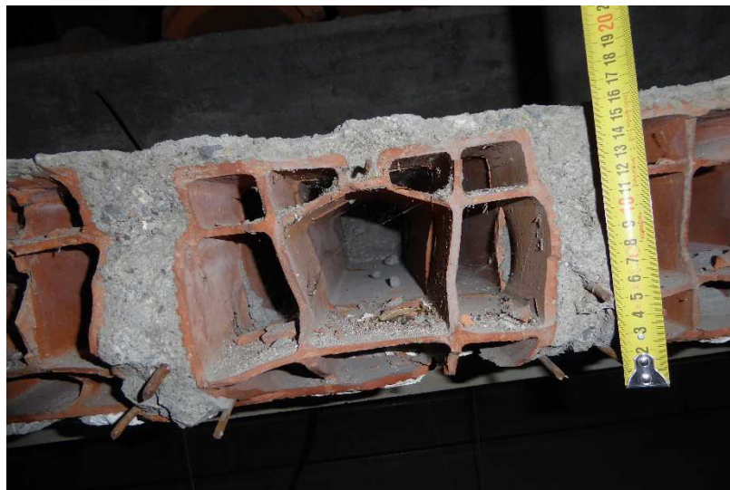
Figura 31: Solaio S7 – particolare altezza laterizio.
