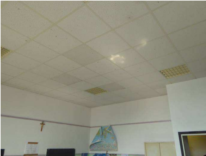
Figura 16: Aula A17 – Controsoffitto in lamierino e pannelli Foto P1080330 P1080311
