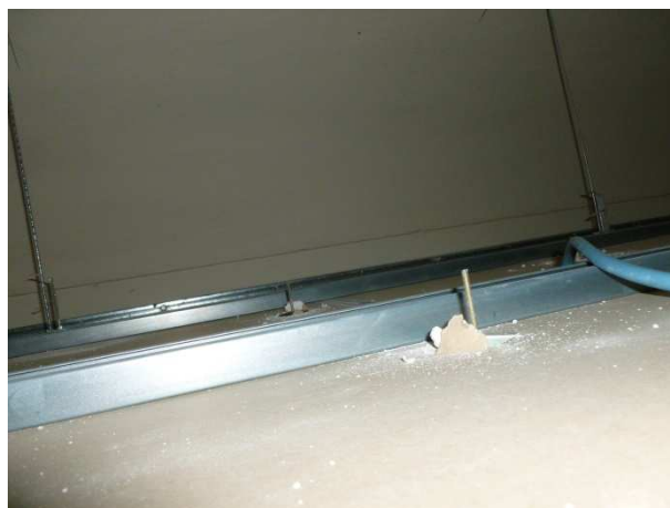
Cavi elettrici appesi ai pendini con nastro isolante Plafoniere fissate in maniera non idonea
