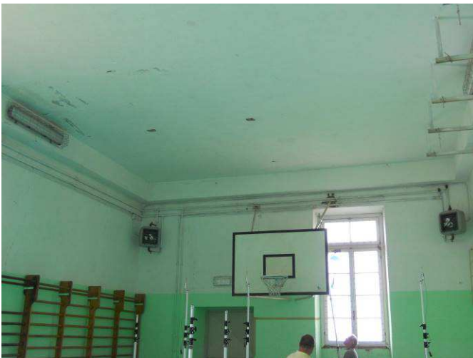
Figura 10: solaio palestra – Foto 2333
