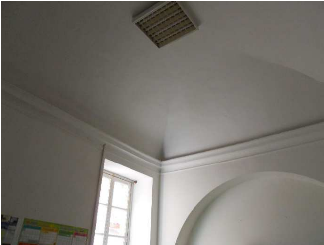
Figura 4: Aula A2 – Volta a botte con testata di padiglione Foto 2312 2311
