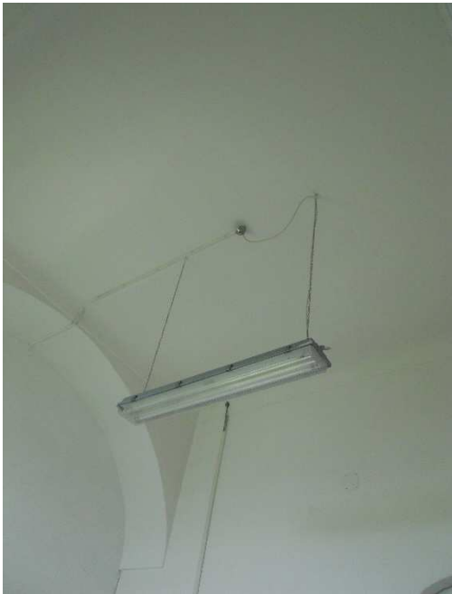
Figura 12: Aula A11 volta a schifo molto schiacciata Foto schiacciata - Foto 2379
