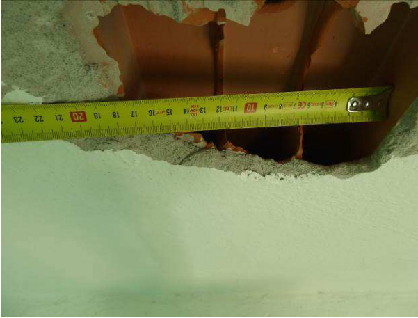
Figura 22: Sondaggio palestra – particolare dimensioni tavelloni.
