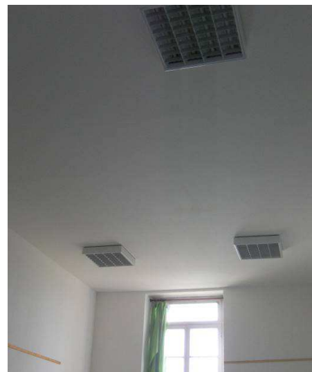
Figura 7: Aula A5 – controsoffitto in cartongesso Foto 2365
