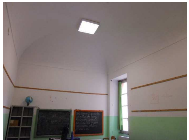
Figura 2: Aula A1– Volta a botte con testata di padiglione – Foto 2304
