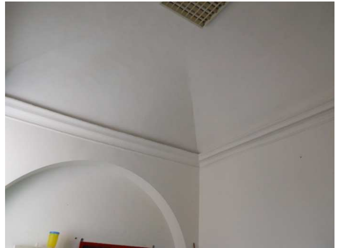
Figura 5: Aula A2 – Volta a botte con testata di padiglione - Foto 2311
