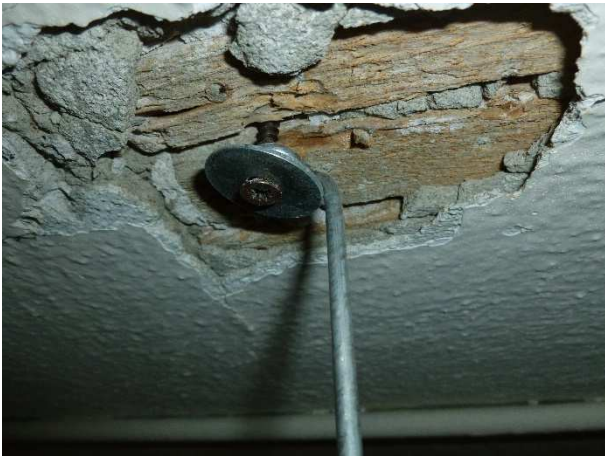
Figura 24: Aula A7 – particolare aggancio di fissaggio al - canniccio
