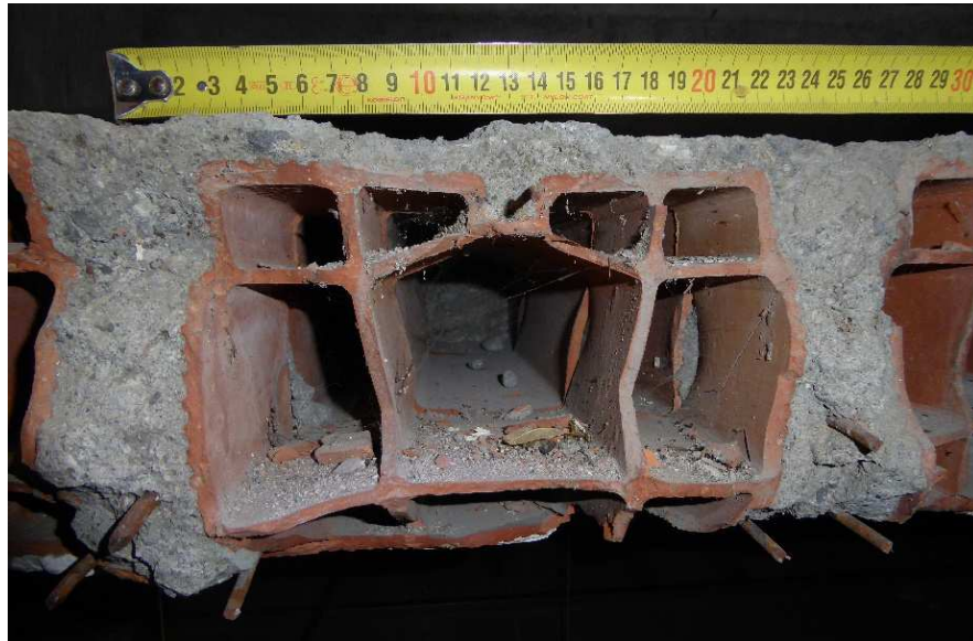
Figura 30: Solaio S7 – particolare larghezza laterizio.
