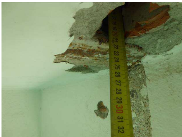
Figura 22: Sondaggio palestra – particolare dimensioni tavelloni.
